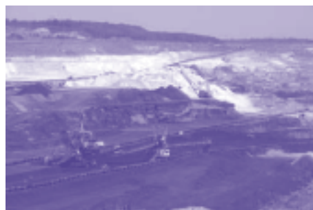
▲ Энергоэффективность в действии — ЕБРР профинансировал систему экскаватора, конвейера и распределителя на новом участке бурого углю бассейна «Колубара»
